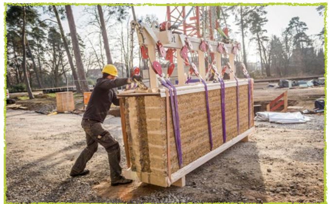
Die 384 Stampflehmblöcke wurden zu 12 Meter hohen, selbsttragenden Wandscheiben geschichtet. Die Fertigung der Stampflehmfertigteile erfolgte in den ehemaligen Panzerhallen auf dem Gelände, was Transportwege einspart.
