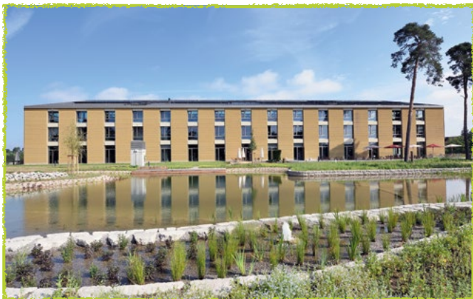
Die 384 Stampflehmblöcke wurden zu 12 Meter hohen, selbsttragenden Wandscheiben geschichtet. Die Fertigung der Stampflehmfertigteile erfolgte in den ehemaligen Panzerhallen auf dem Gelände, was Transportwege einspart.
